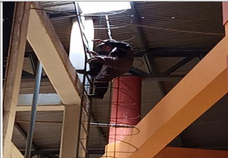
FOTO 1: Mantenimiento de tanque
